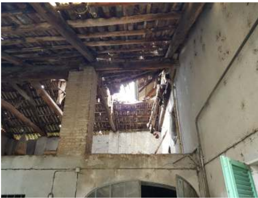
Attuale situazione della copertura in legno con grosse aperture che favoriscono l'ingresso di acque ed il conseguente deterioramento delle strutture murarie sino al collasso.
