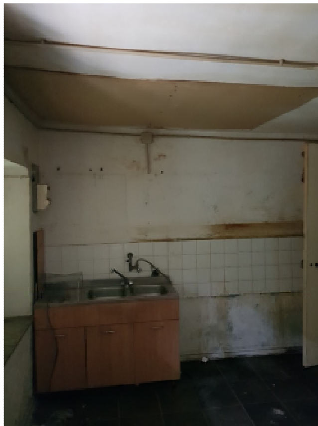
Solaio e pavimento piano primo realizzato contravi in legno, e tavolato. Osservando pavimento e soffitto si vedono notevoli deformazioni dovute al sottodimensionamento degli elementi ed al loro pessimo stato di usura.
