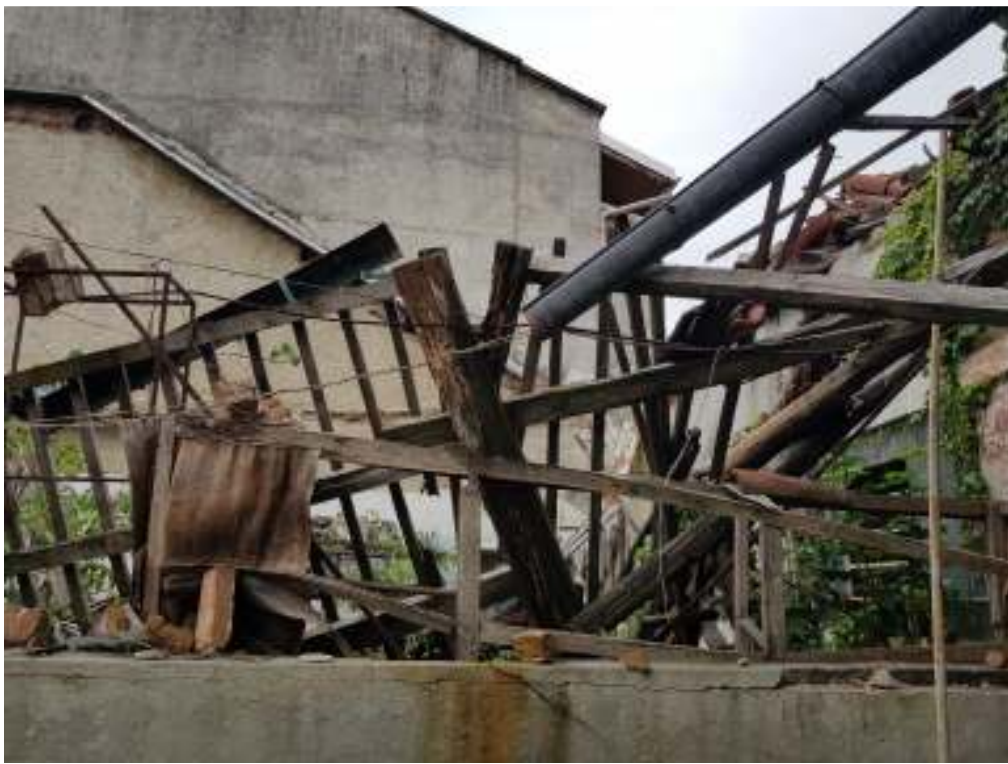
Particolare dell'edificio collassato in cui si può notare il sottodimensionamento strutturale e lo stato di marcescenza degli elementi lignei.
