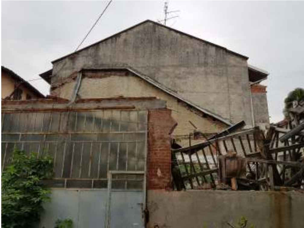
Immobile secondario collassato causa marcescenza copertura in legno e sottodimensionamento strutture
